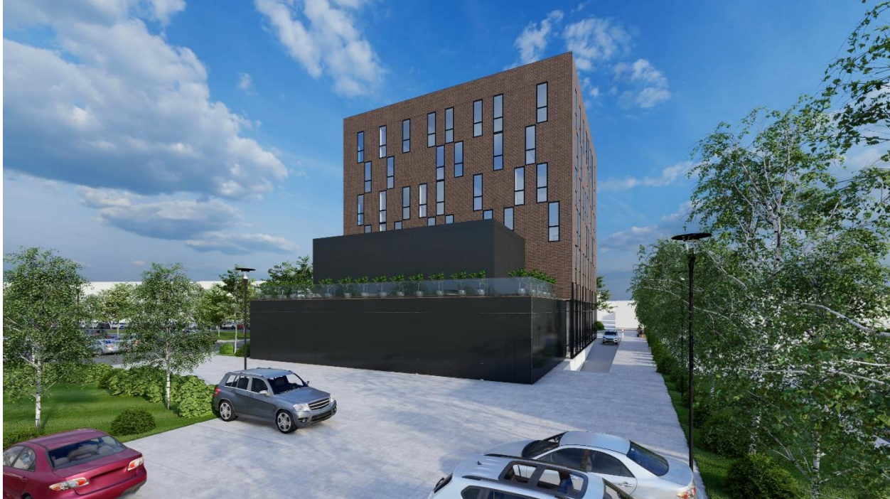
Sl. 8 – zadnja fasada
